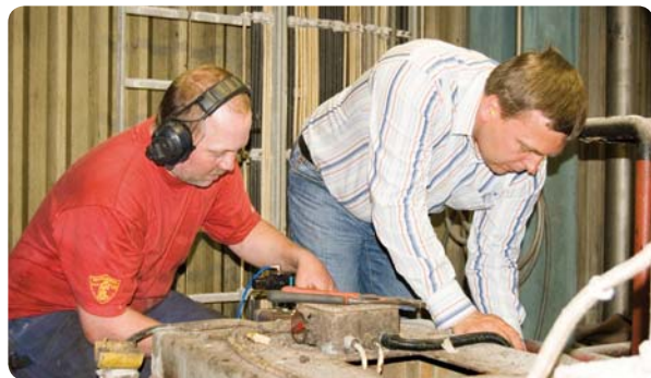
Engagerad mekaniker från Bäckhammars bruk monterar HISS utrustning på sotblåsare med Mikael Niklasson
